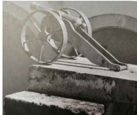
Cañón del observatorio meteorológico; tronaba a las doce del día mediante un mecanismo accionado por un lente de aumento.
